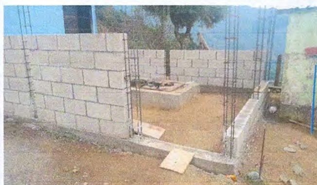
Foto 2: AVANCE DE LA COCINA
