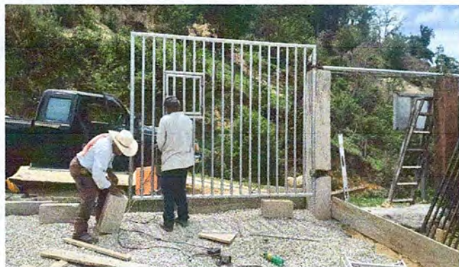
Foto 1: AVANCE DEL PORTÓN
