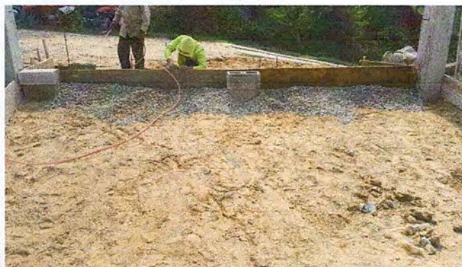
Foto 3: AVANCE DE PATIO
