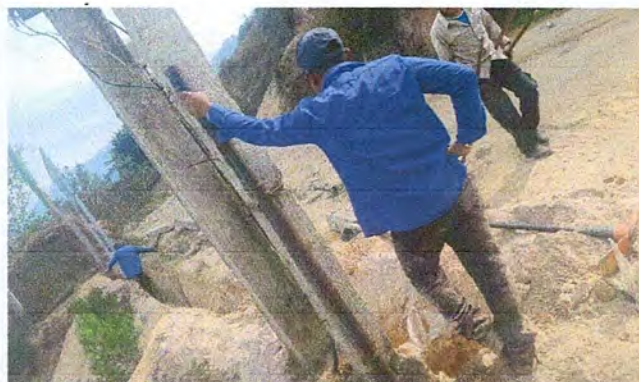
Foto 4: AVANCE DE CERCO PERIMETRAL
